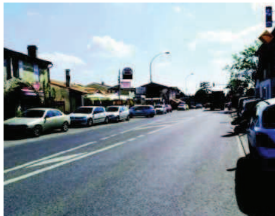
La chaussée accueillera un plateau ralentisseur et une séparation centrale. PHOTO MARTINE GUILLOT
